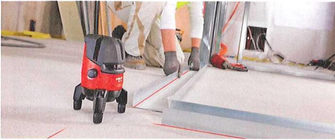
/ Selbstnivellierend in drei Sekunden: Die Laserlinien können beim PM 4-M einzeln geschaltet werden und haben mittels Empfänger eine Reichweite von bis zu 50 m.
