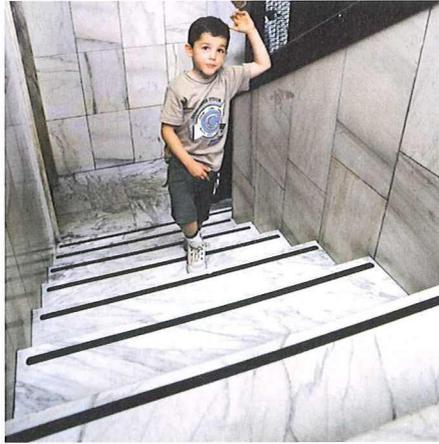
sowie für die Nasszone an. Die Produkte weisen je nach Einsatzzweck eine mit Mineralkörnung bedeckte oder strukturierte Oberfläche auf. Für den Einsatz auf Treppen geeignet ist der Universalbelag oder die verformbare Variante. Letztere passt sich dank einer Weichaluminiumfolie als Trägermaterial unebenen Untergründen an und kommt sogar auf Riffelblech zum Einsatz.
